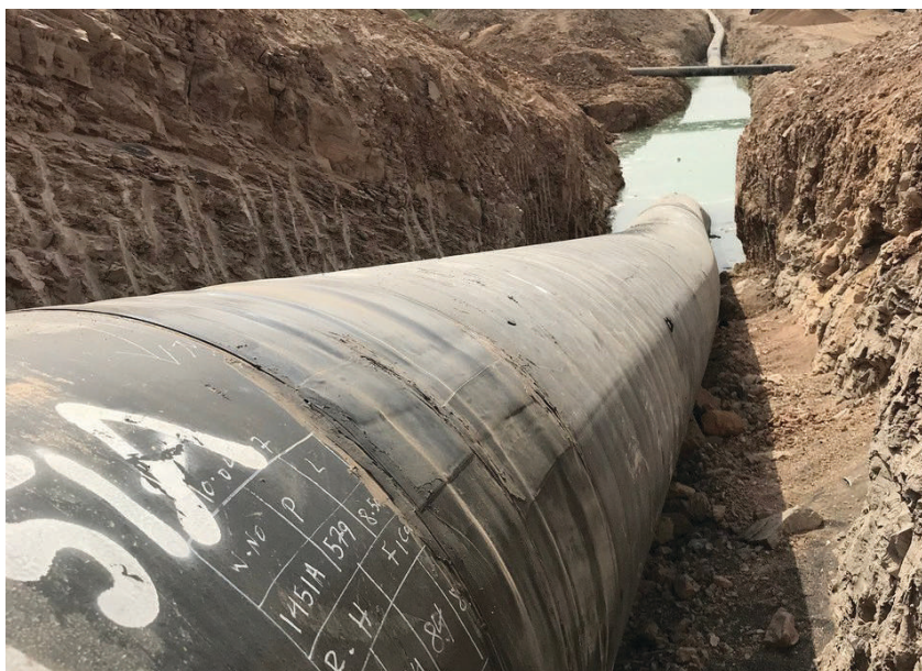
غلاف انقباضی حرارتی / پروژه خط لوله بندر عسلویه / شرکت ایران آروین
