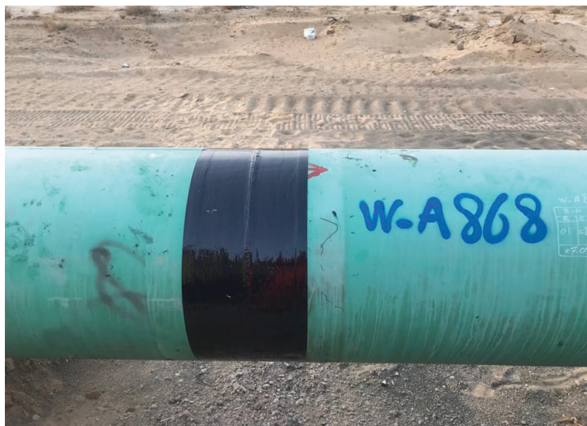
ایوکسی سرجوش دما بالا، پروژه احداث خط لوله ۳۰ اینچ بندر عباس / لافت / گورزین
