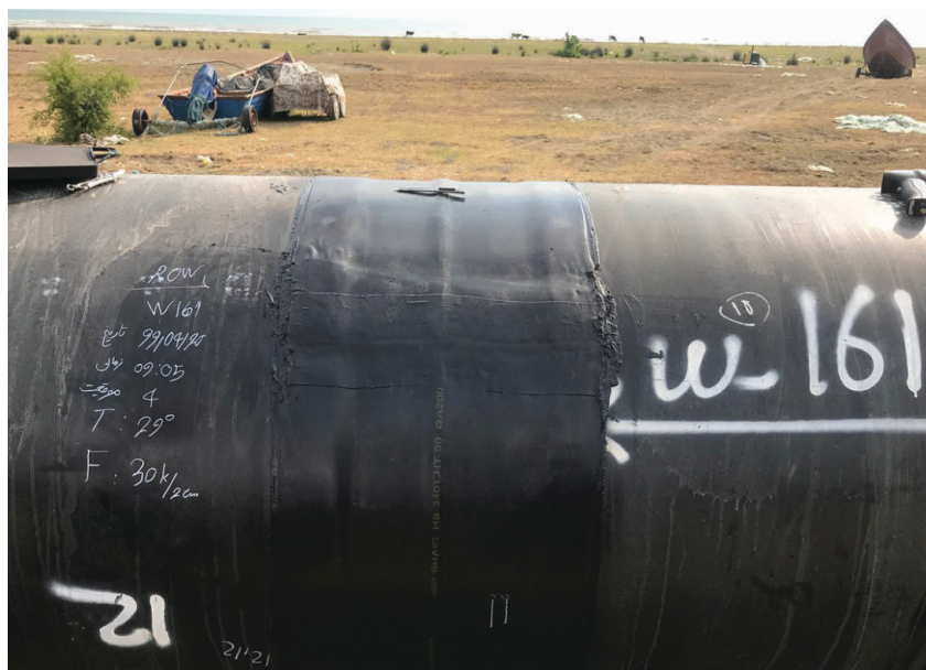
غلاف انقباضی حرارتی / پروژه خط لوله ۴۲ اینچ / رشت / چلود
